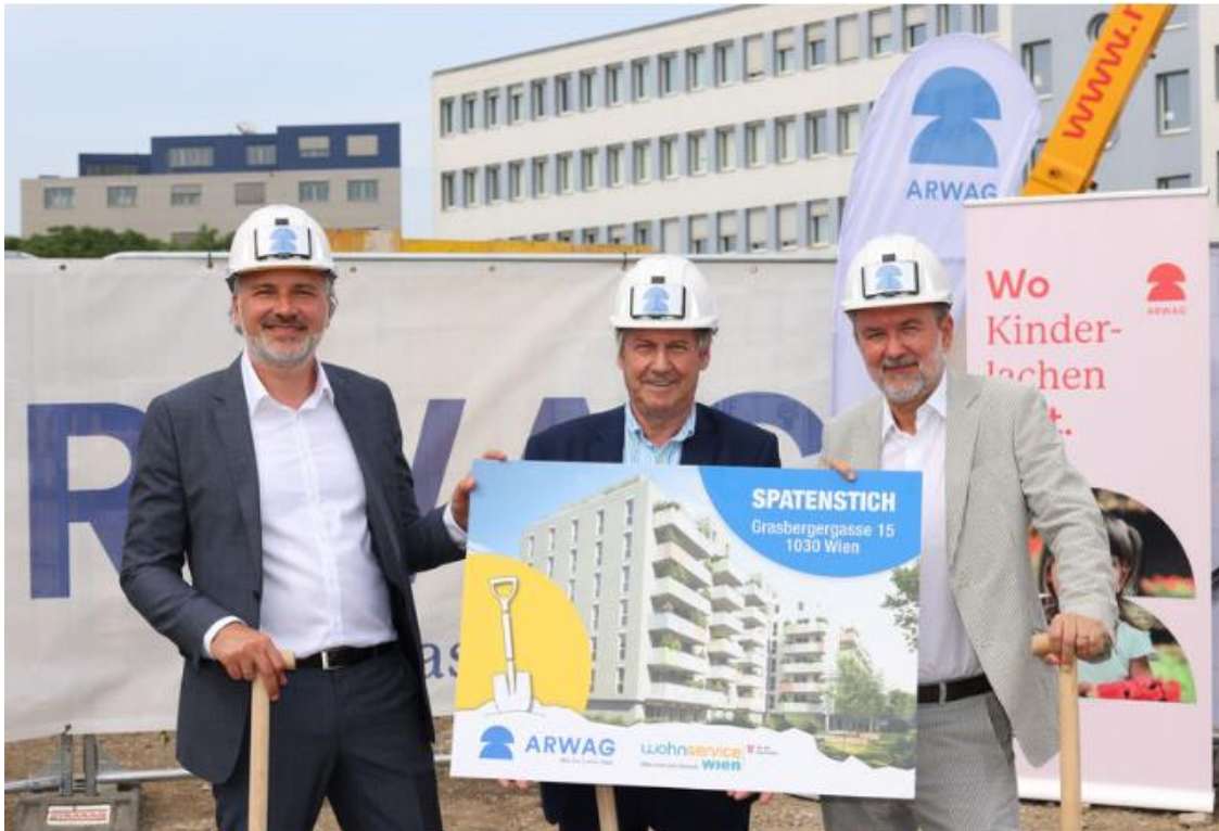
ARWAG-Vorstand Christian Raab, BV Erich Hohenberger und ARWAG-Vorstand Thomas Drozda (v.l.n.r.) markierten den Beginn des Bauprojekts.
