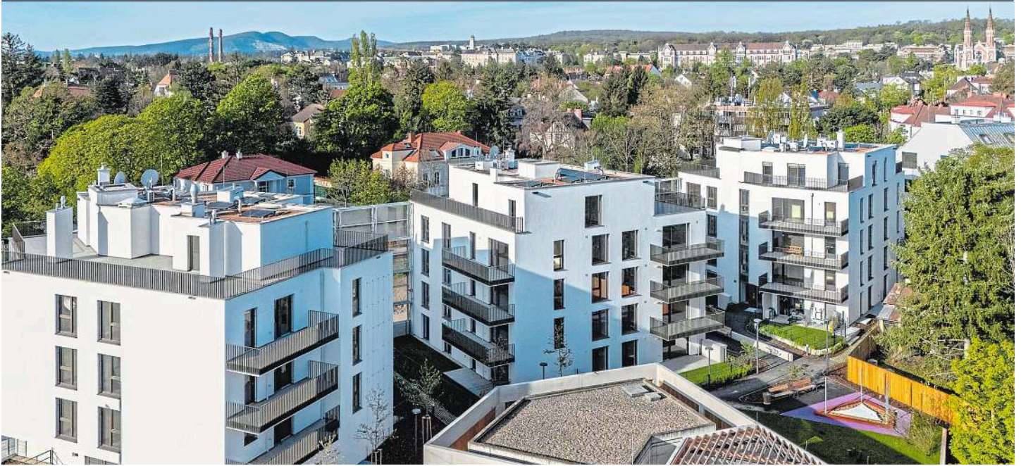
Neubau Noah+ in der Lainzer Straße 172 von der Arwag: Ein Teil der Wohnungen wird mit Finanzierungsvariante angeboten
