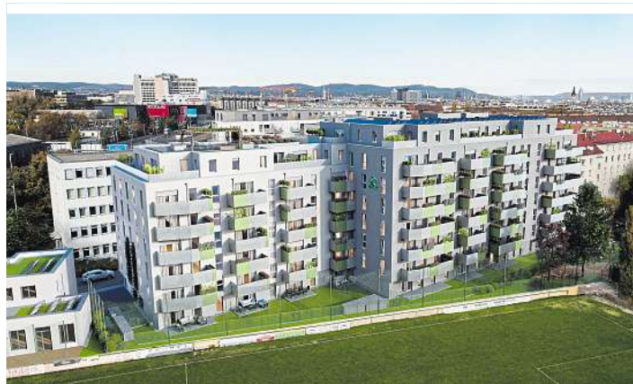
In Bau: Wohnbau der Arwag im dritten Bezirk in Wien mit 108 Wohnungen
